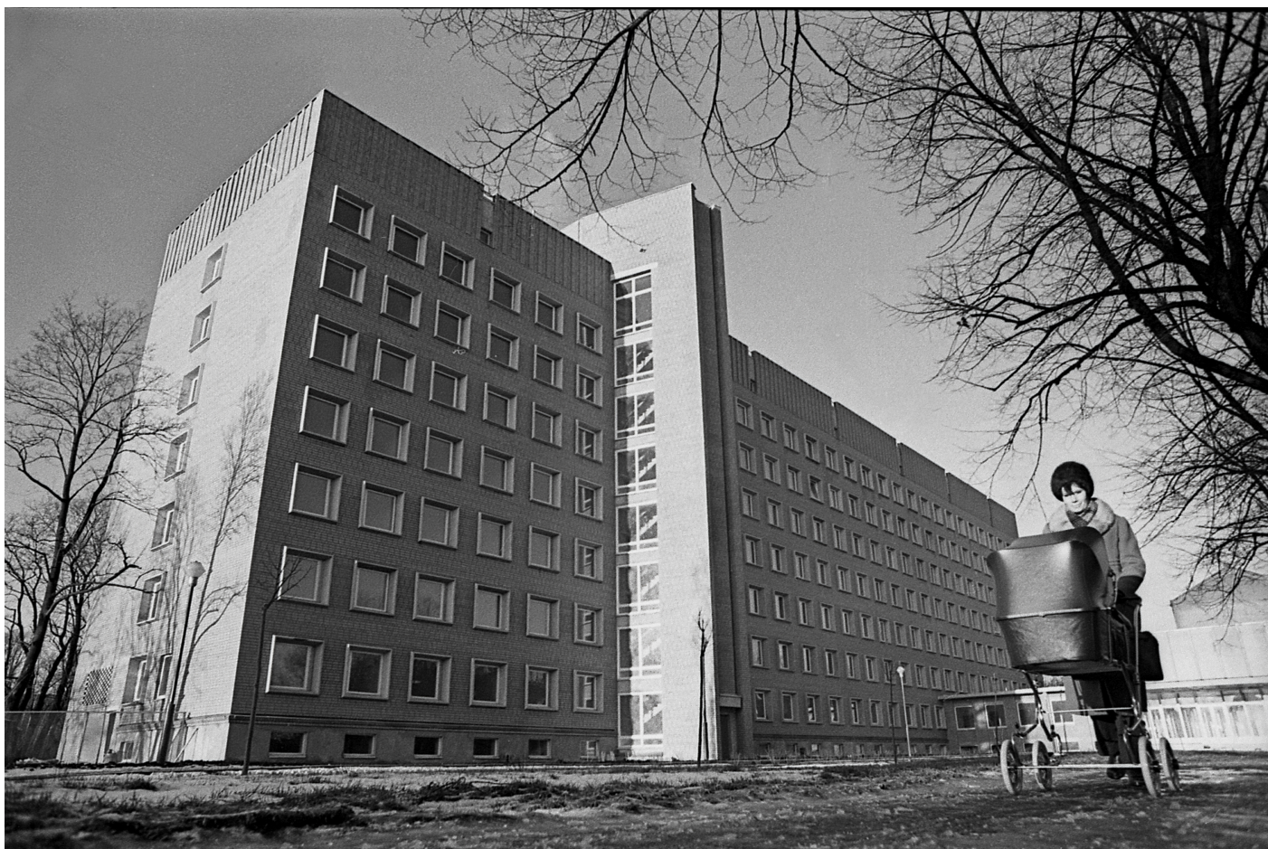
Rīgas pilsētas 1. dzemdību nams Miera ielā 45. 1978. gada 8. marts. Foto: Uldis Pāže.
